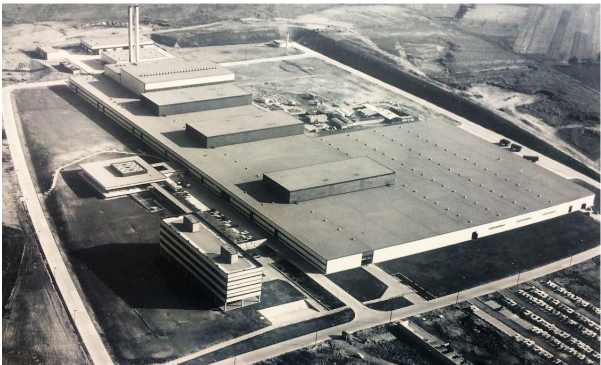
Übersichtsfoto der 1. Ausbaustufe des Östringer Nylonwerks von 1965
